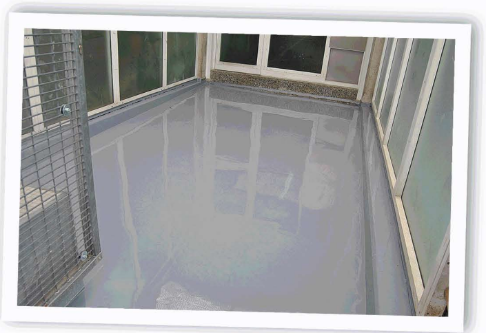
Bereits Ende April wurde in die Außengehege für die Säuger frischer Estrich eingebracht (oben), der mithilfe des Landes Baden-Württemberg finanziert werden konnte. Bis zur "naturnahen Einrichtung" ist es aber noch ein weiter Weg.
